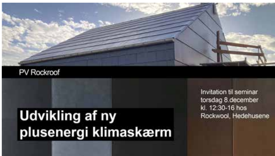
Tagintegrerede solceller på demohus Nederst: solcellefarver
