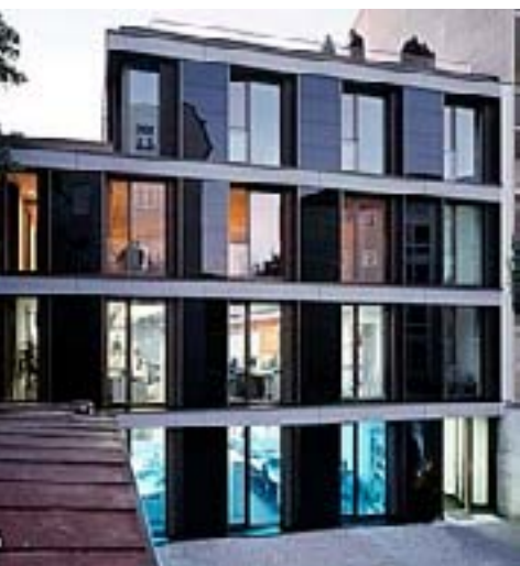
Ombygning og udvidelse af baghus A+P Archtekten (2004)
